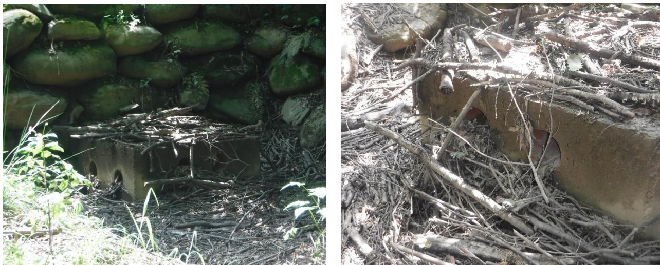
Figura 9: manufatto di ingresso
