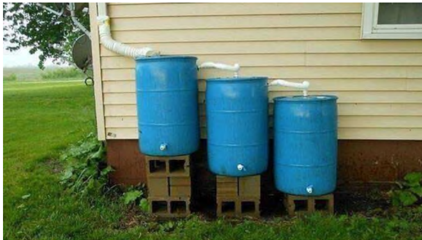
Figura 22: raccolta dell'acqua dal pluviale all'interno di "rain barrels"
