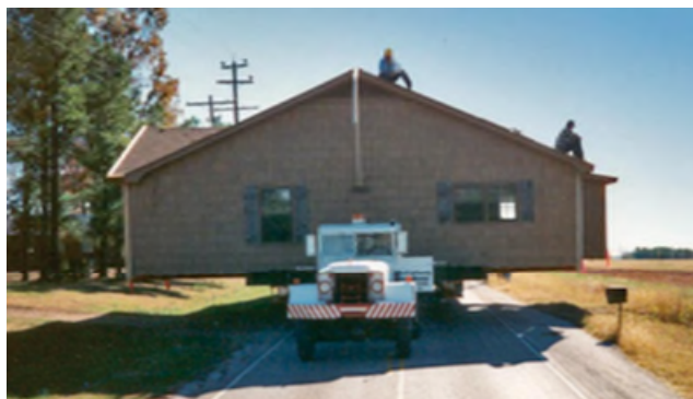
Figura 12: esempio di rilocazione di una abitazione di medie dimensioni negli Stati Uniti
