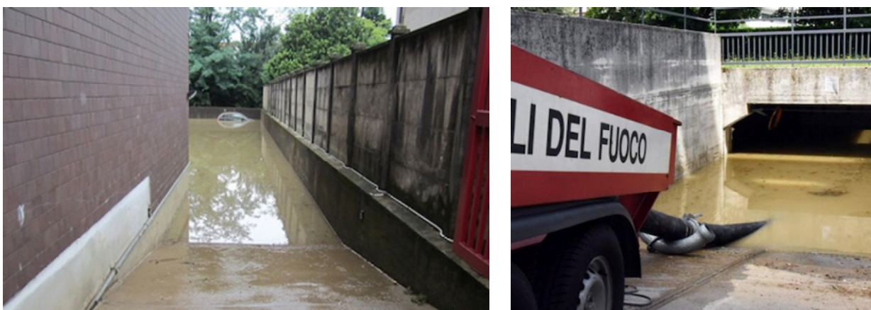
Figura 3: esempio di allagamento di spazi depressi, indotti da eventi caratterizzati da battenti modesti sul piano stradale (Bovisio e Longuelo)
