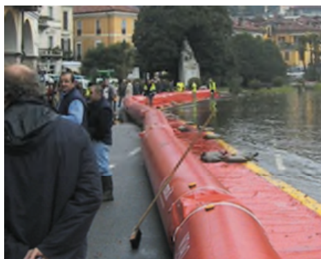
Figura 8: esempio di sistema di diga flessibile a riempimento pneumatico ( http://noaq.com/en/products/ )
